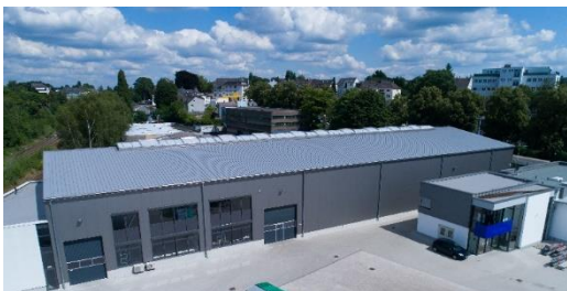
Technikcenter mit Vermahlungsanlagen, Qualitätsprüfung, Spritzgiesstechnik und Laborextruder
